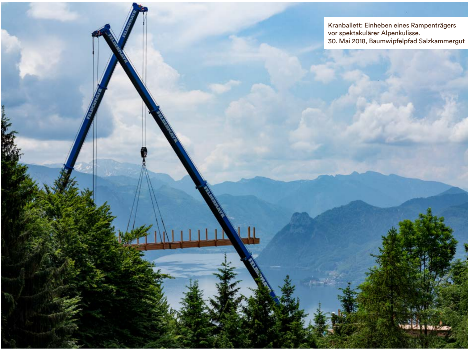
Die Pfadträger mit dem Gehbelag ruhen auf Dreibeinstützen aus Douglasienstämmen. Alles läuft nach Plan! 30. Mai 2018, Baumwipfelpfad Salzkammergut
