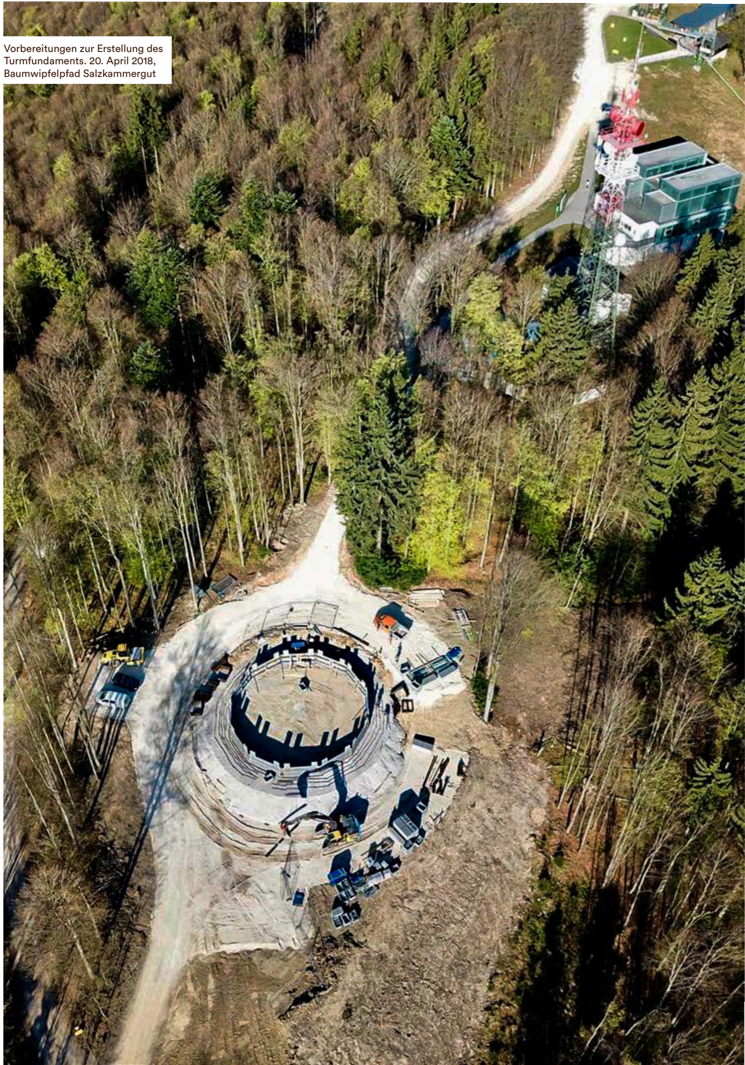
Hier entsteht das Kassen- und Bürogebäude. Begonnen wird mit der Vorbereitung der Bodenplatte. 24. April 2018, Baumwipfelpfad Salzkammergut
