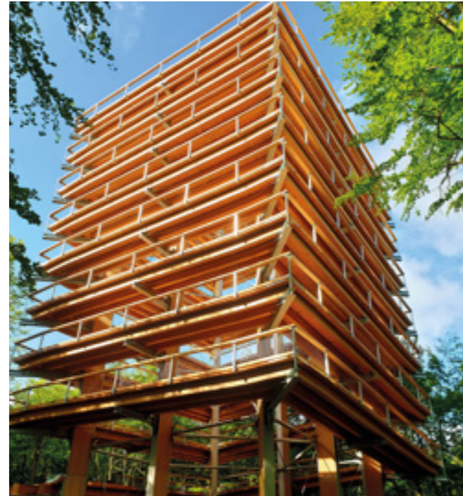
► Der 33 Meter hohe Aussichtsturm des Baumwipfelpfad Usedom ist bereits fertiggestellt. Zum ersten Mal hat ein Turm der eak eine quadratische Grundform.
