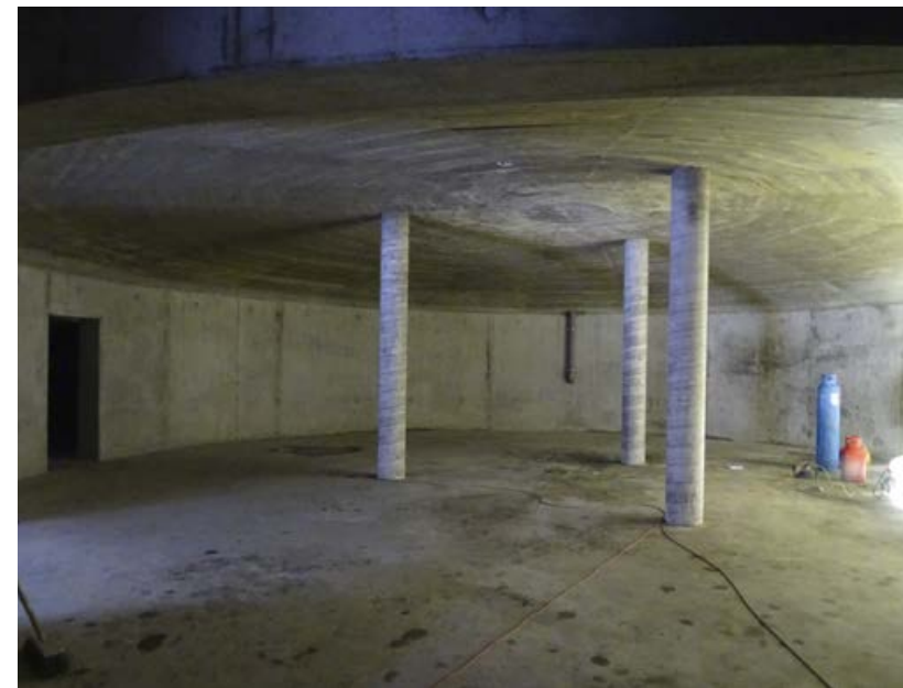
▶ Fertiggestellter Rohbau der Wurzelhöhle, Baumwipfelpfad Krkonoše
